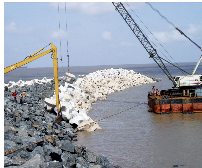
Exemple de construction d'une digue en enrochements.
