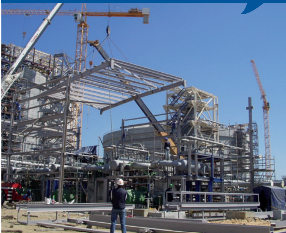
Phase de construction d'un terminal méthanier
