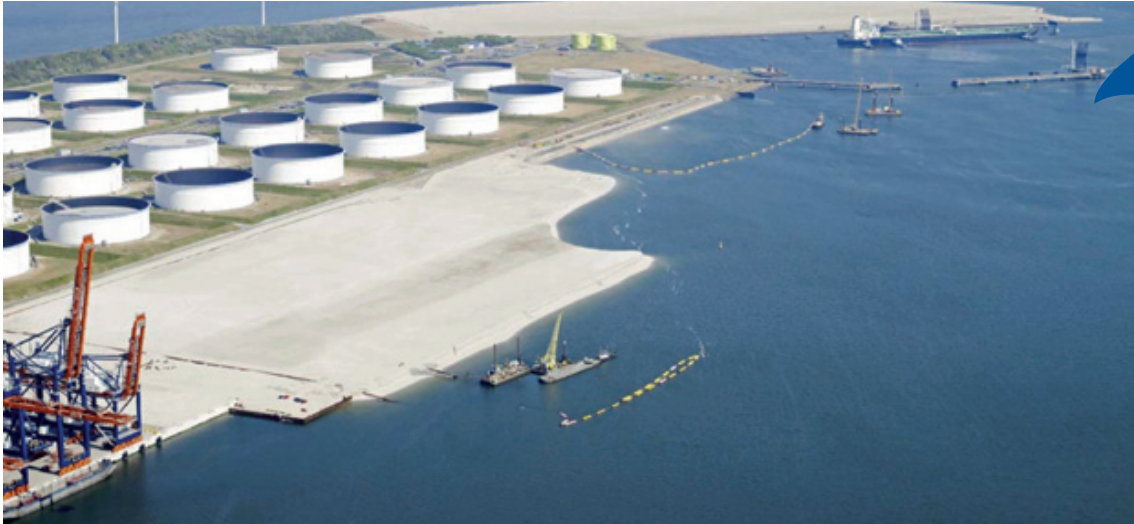
Opération de dragage dans le port de Rotterdam
