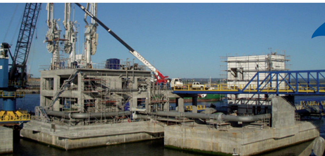
Construction de la jetée d'un terminal méthanier
