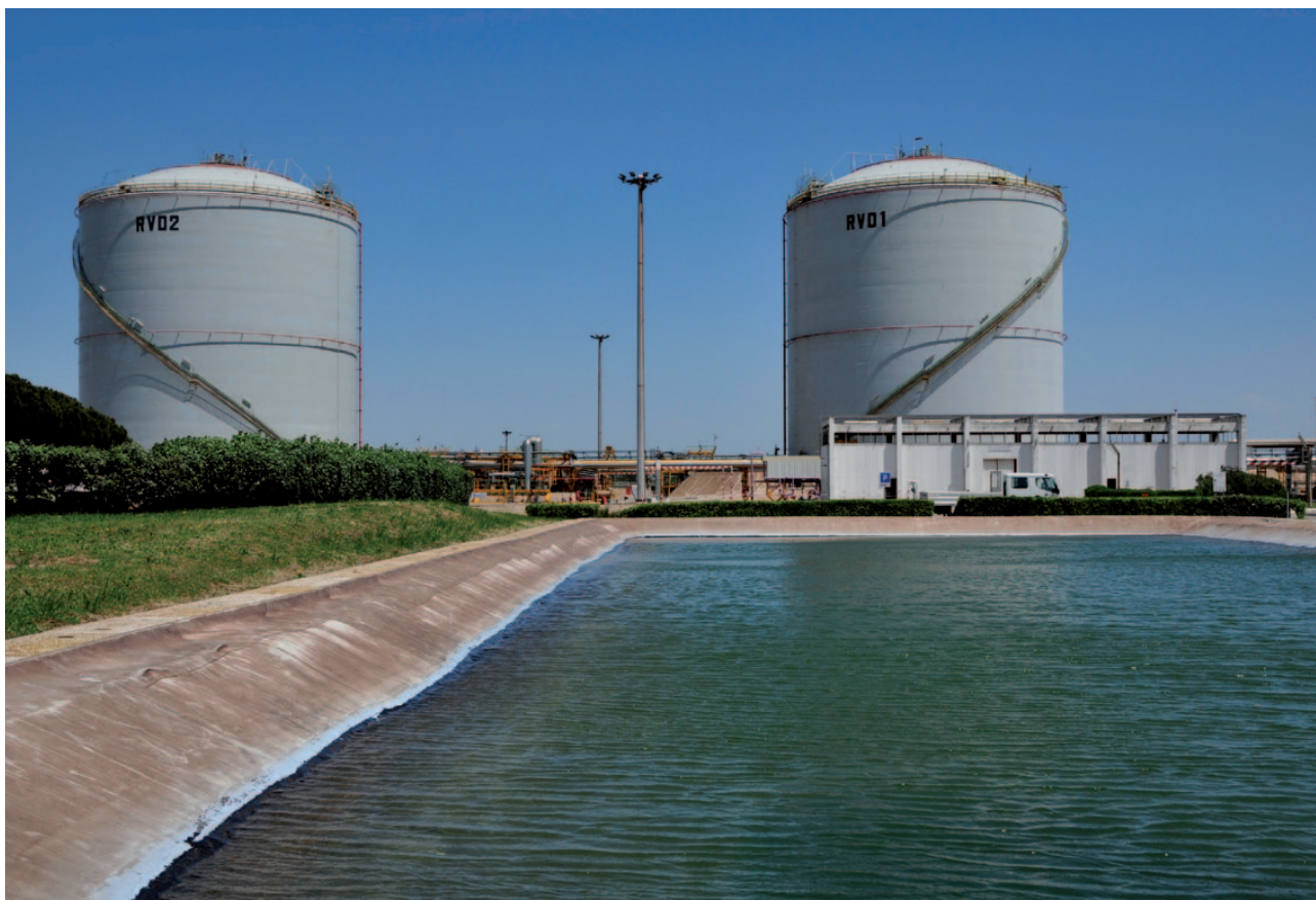
Réservoirs RV 01 – RV 02 du terminal de Fos Tonkin
