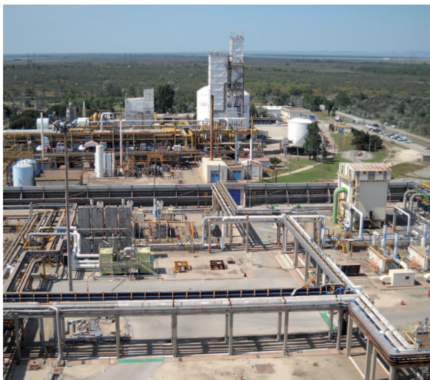
Usine Air Liquide adjacente au terminal de Fos Tonkin
