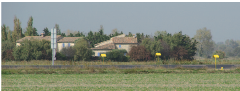
Bornes balisant le réseau de transport de GRTgaz
