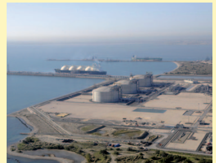
Terminal méthanier de Fos Cavaou
