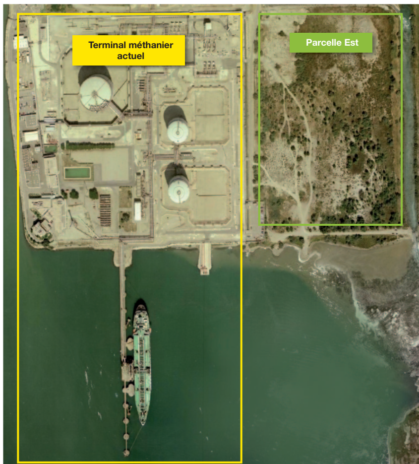
Le terminal méthanier de Fos Tonkin avec la parcelle Est, où pourraient être installés le nouveau réservoir et ses équipements adjacents
