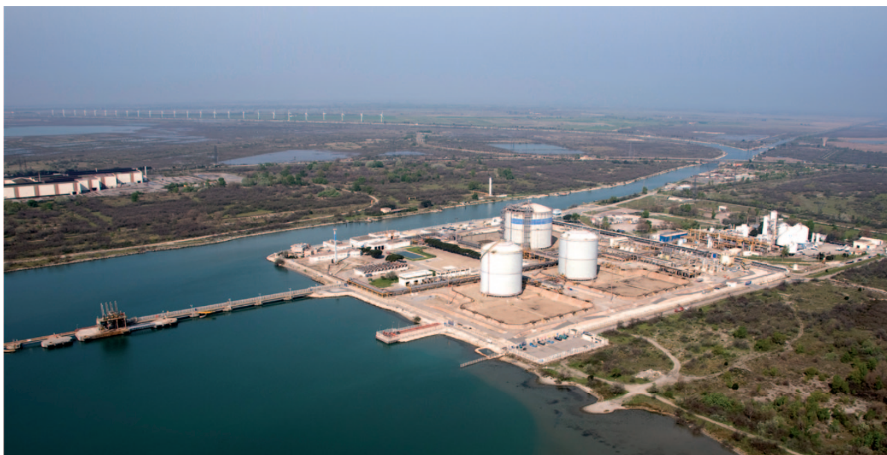
Le terminal méthanier de Fos Tonkin
