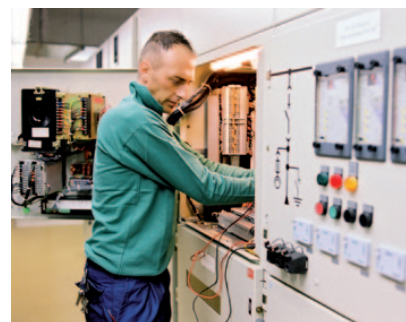
Intervention sur l'instrumentation du terminal
