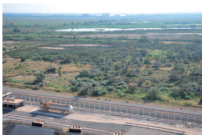
Parcelle à l'est du terminal de Fos Tonkin
