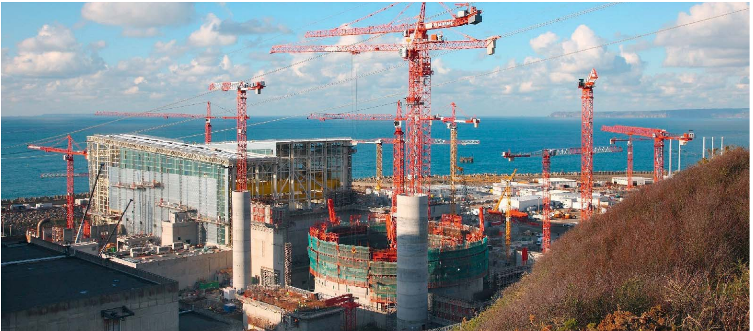
Construction du premier réacteur EPR en France, à Flamanville.
