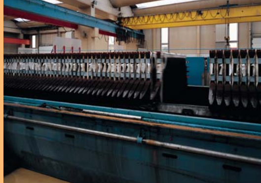
• Vue aérienne des tranches de Seine aval "Achères II, III et IV"
