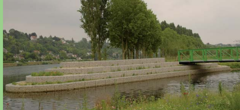
• Vues sur le nouveau canal de rejet unique de Seine aval
