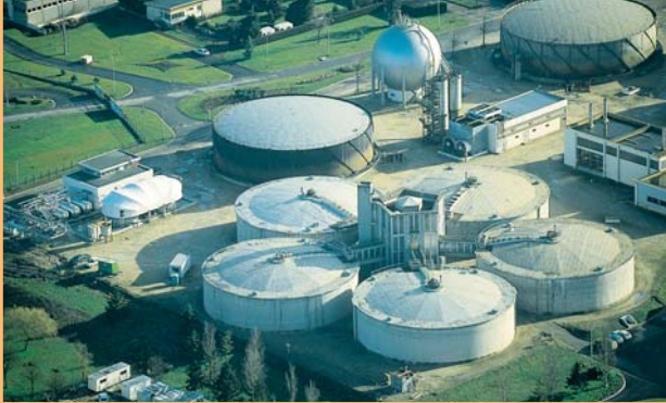
• Turbine à gaz et installation des digesteurs générateurs de biogaz à Seine aval
