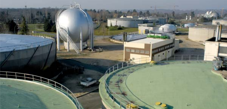
• Zone de Biogaz à Seine aval
