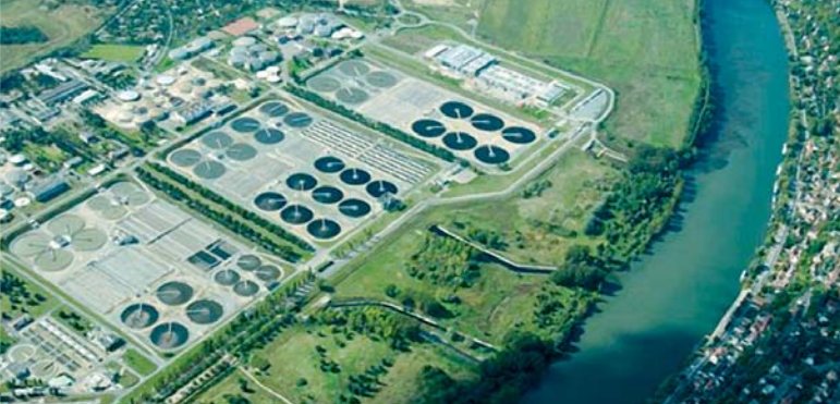
• Seine aval, bassins de traitement des eaux usées
