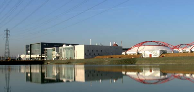
• Extension de l'usine Seine amont
