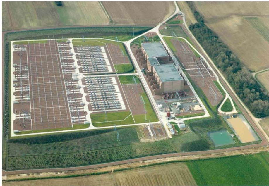
exemple de station de conversion alternatif / continu dans un poste : la station IFA 2000 (de l'interconnexion France-Angleterre)
