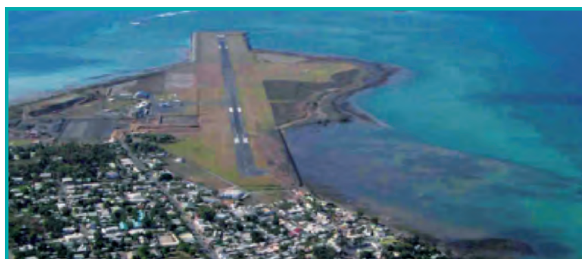
Vue aérienne de la piste depuis le nord
