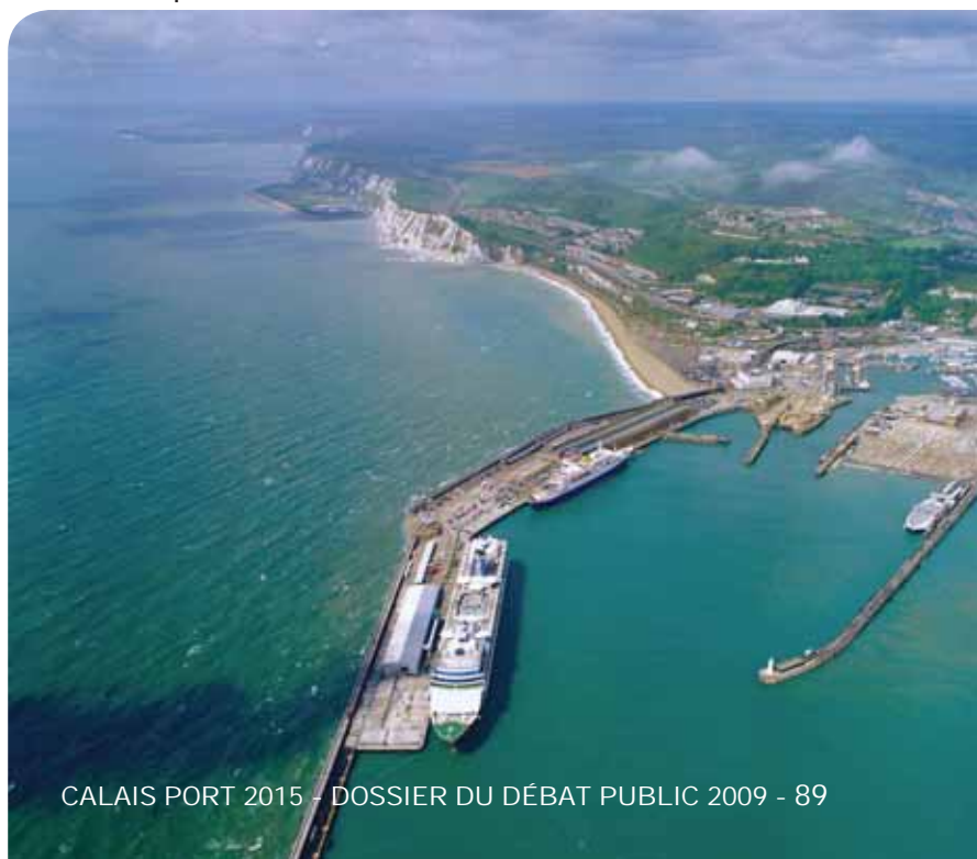
Vue aérienne du port de Douvres - Western Docks - Source : CCI Calais
