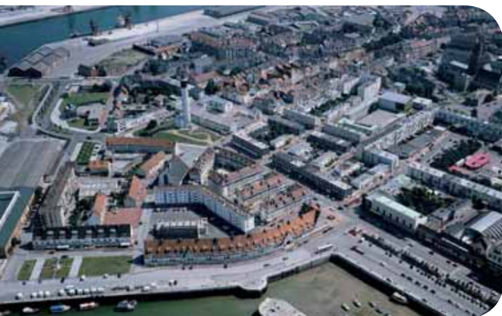
Calais Nord en bordure du bassin de Paradis. ©BCEOM / KERN
