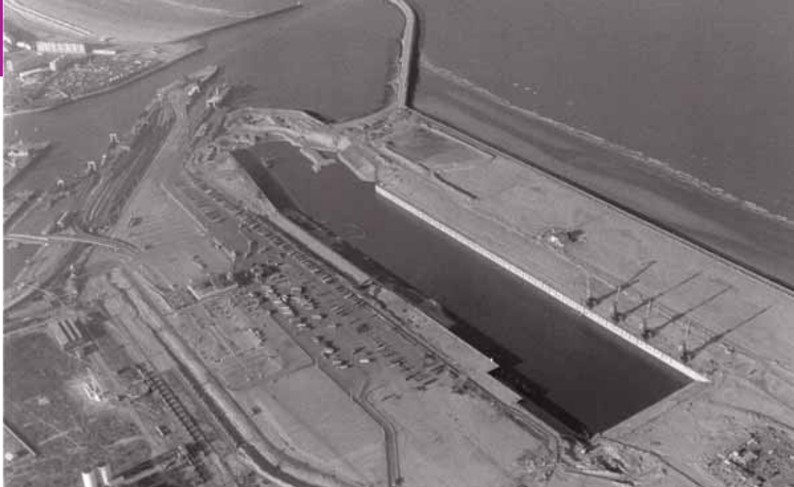
Le bassin Est en cours de construction Source : CCI Calais
