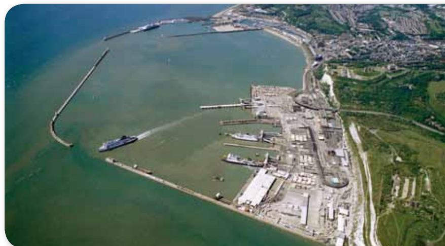
Port de Douvres. [Source cahier d'acteurs - Port de Douvres].
