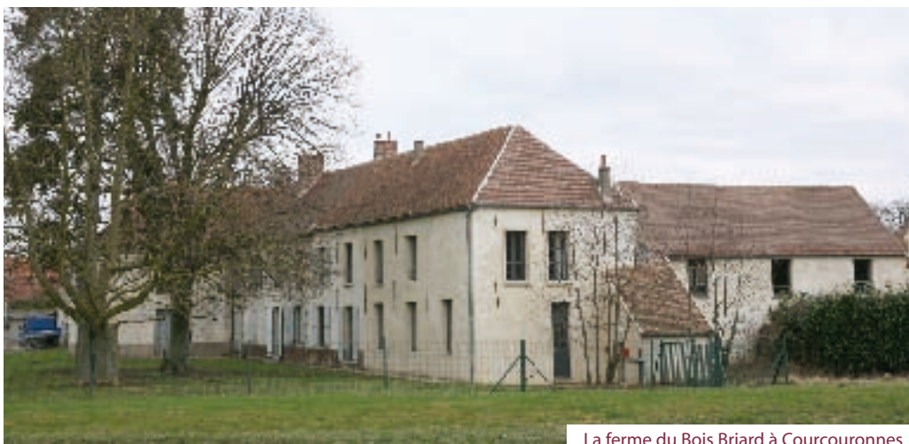
La ferme du Bois Briard à Courcouronnes
