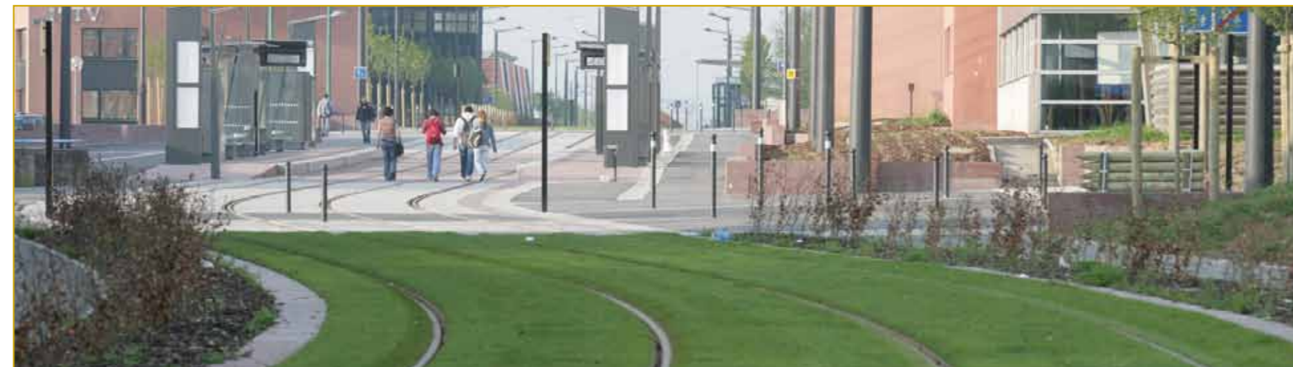
Voies tramway à Valenciennes
