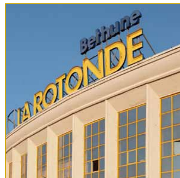
Béthune, pôle commercial de la Rotonde
