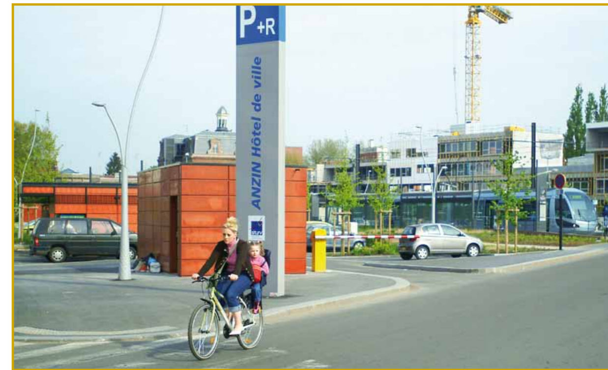
Exemple de parc-relais à Valenciennes
