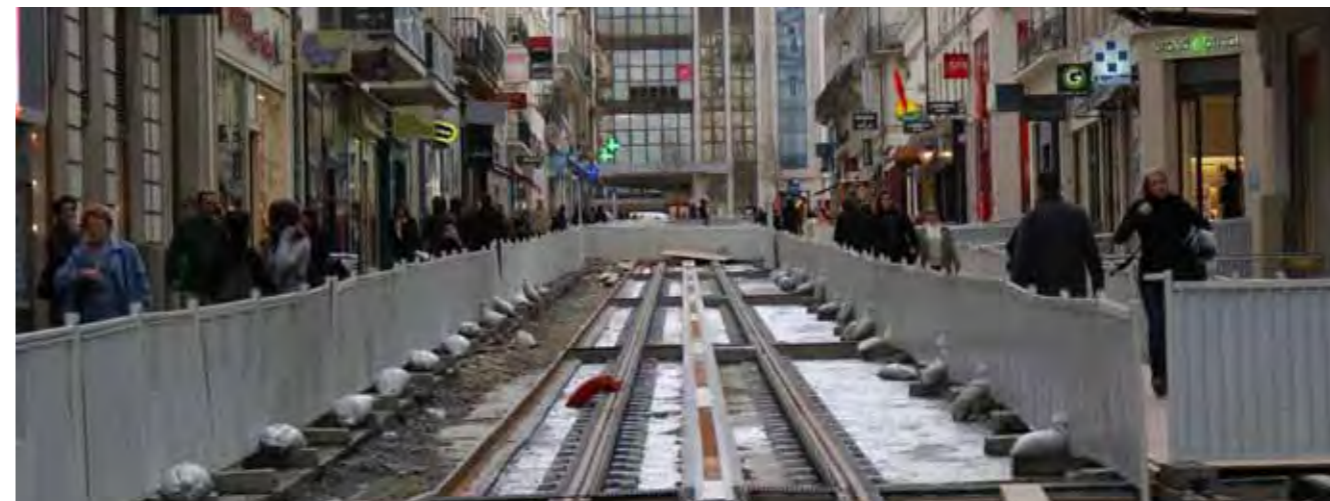
Exemple de cheminements piétons sur plancher bois dans une rue commerçante en travaux pour le tramway à Angers © SMT
