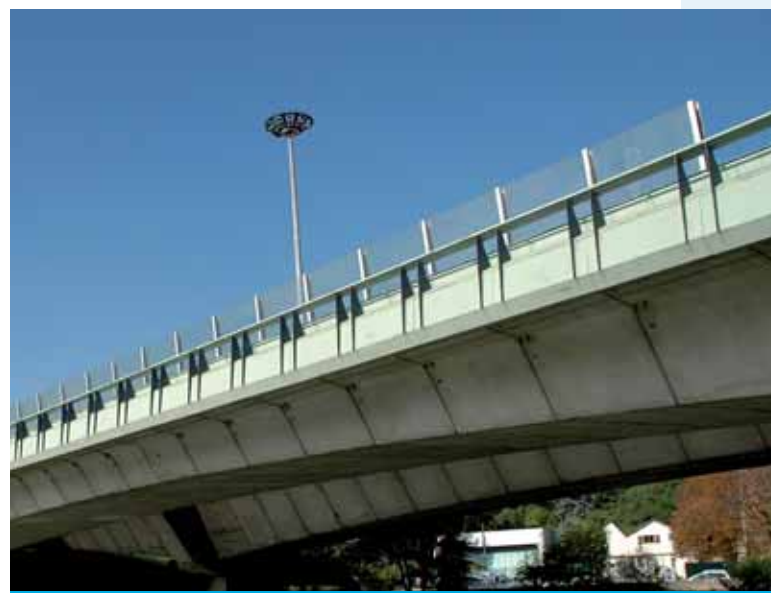
Le viaduc sur la Marne
