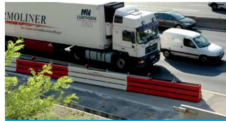
Glissière mobile fermant la voie auxiliaire
