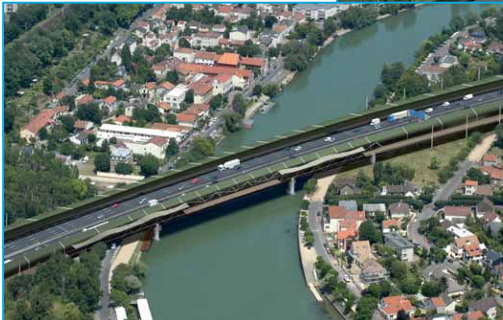
Scénario B - Proposition technique avec poutre treillis
