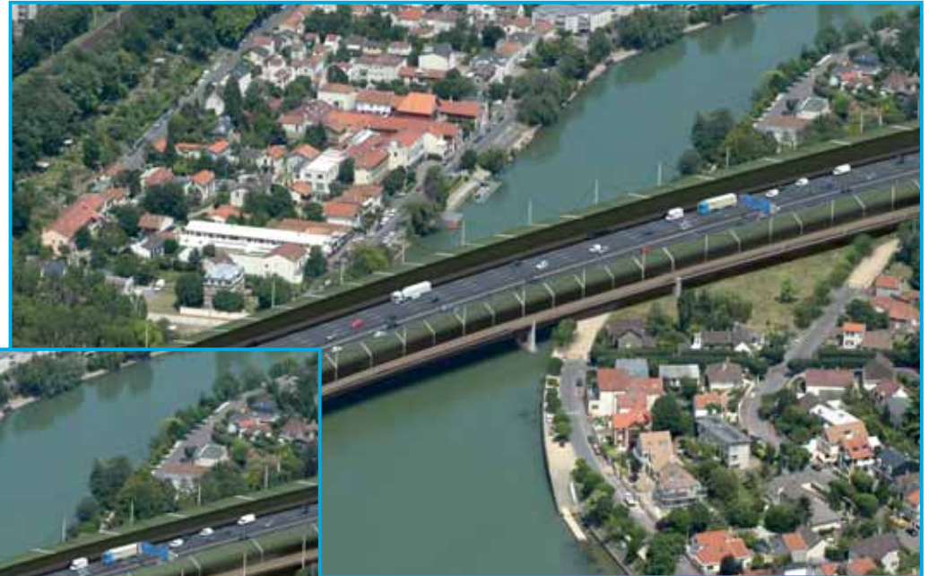
Scénario A - Proposition technique avec caisson métallique
