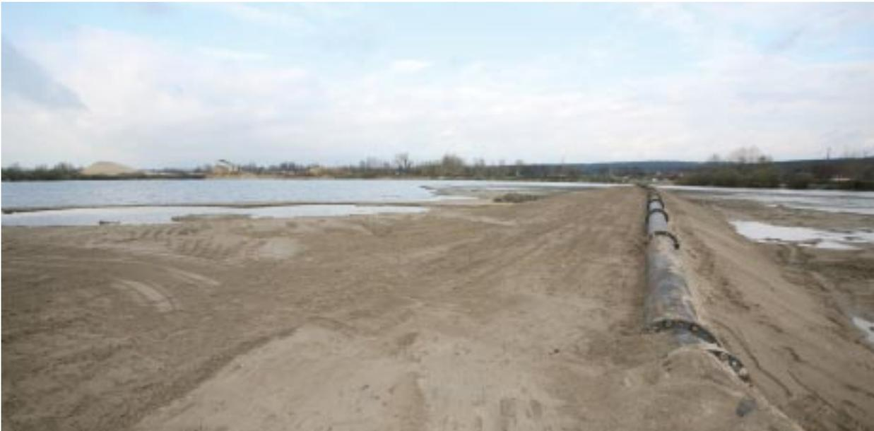
Ballastière d'Yville sur Seine : au premier plan, conduite de refoulement des sédiments
