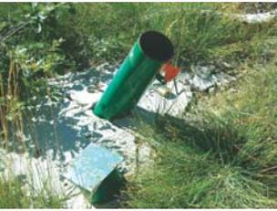
Tête d'un des 60 forages réalisés pour ITER
