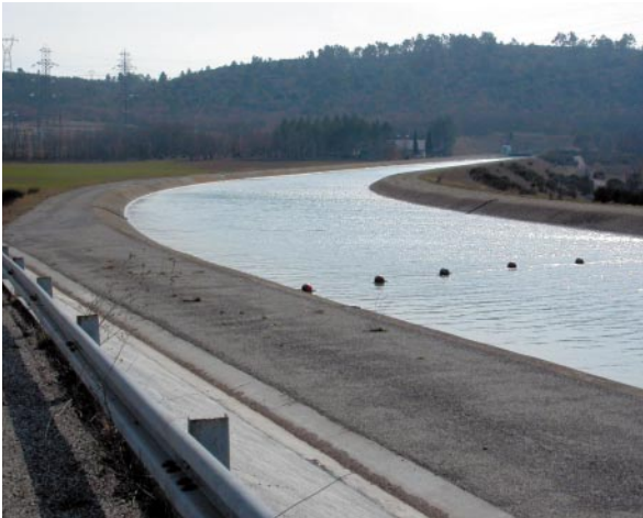
Canal de Provence
