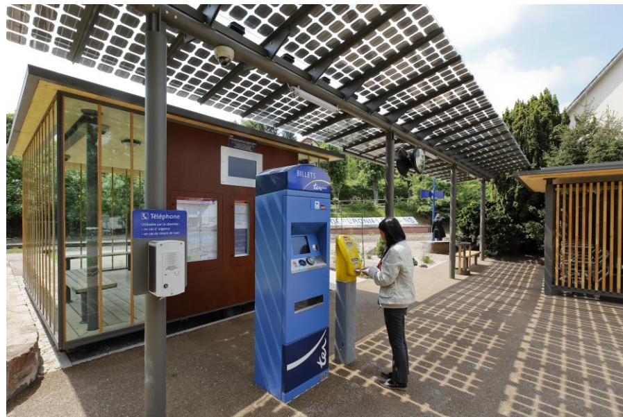
Halte ferroviaire écodurable de Niederbronn-les-bains avec toiture équipée de panneaux solaires (Crédit photo : SNCF-J.M. Dugas)
