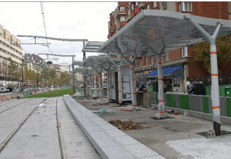
Les portes-LAC ( Lignes Aériennes de Contact) sur le tronçon en cours de réalisation, entre le pont du Garigliano et la porte d'Ivry © Bernard Pedretti/ Mairie de Paris.
