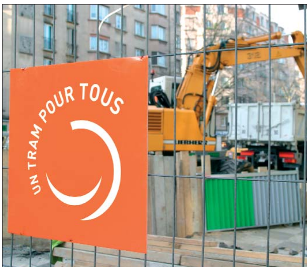
La sécurisation du chantier, un enjeu majeur © Mairie de Paris
