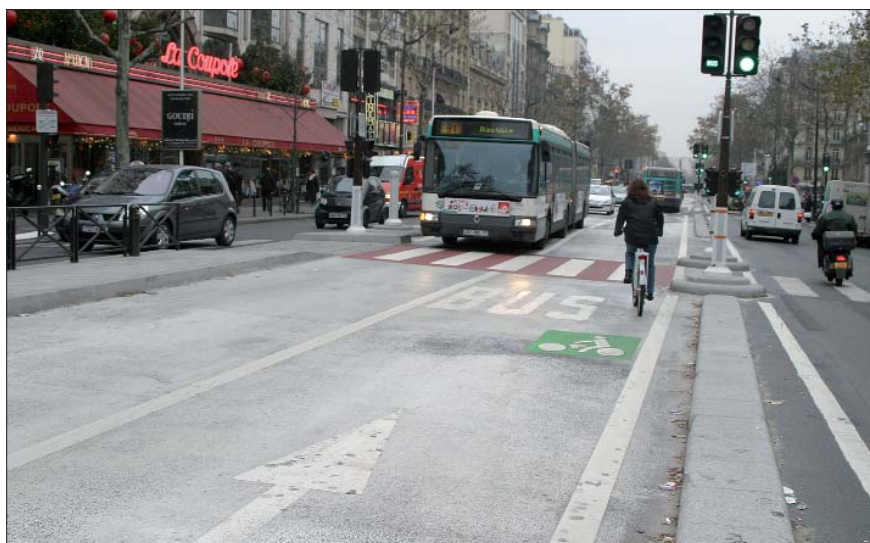
Un nouveau partage de l'espace public au profit des transports collectifs et des circulations douces*. © Mairie de Paris.
