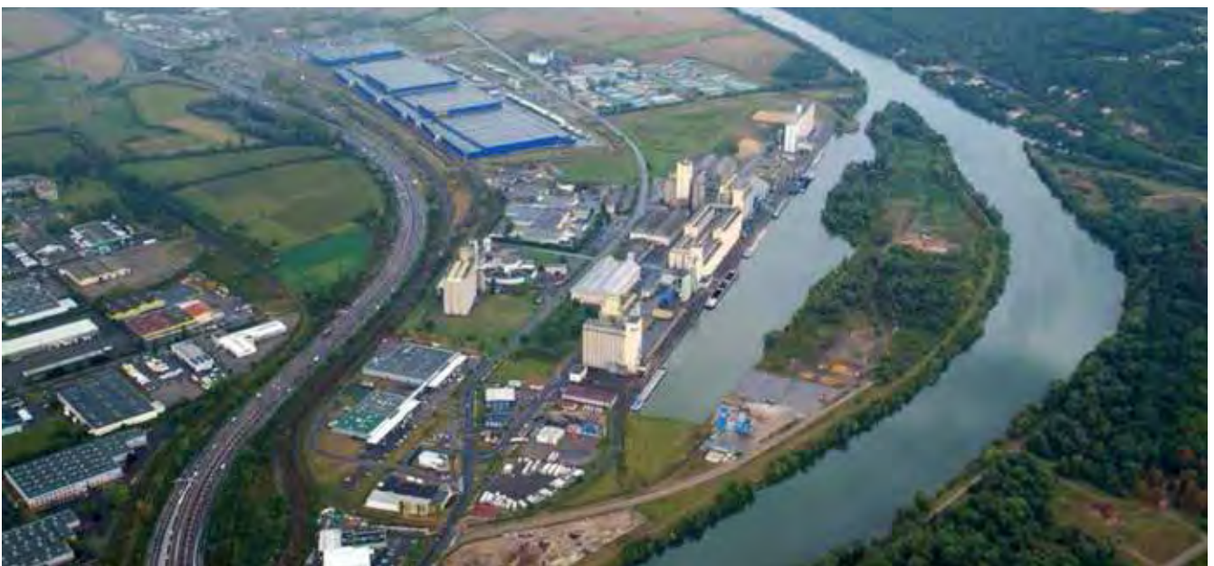
Vue aérienne du Nouveau Port de Metz implanté à proximité immédiate de l'A31
