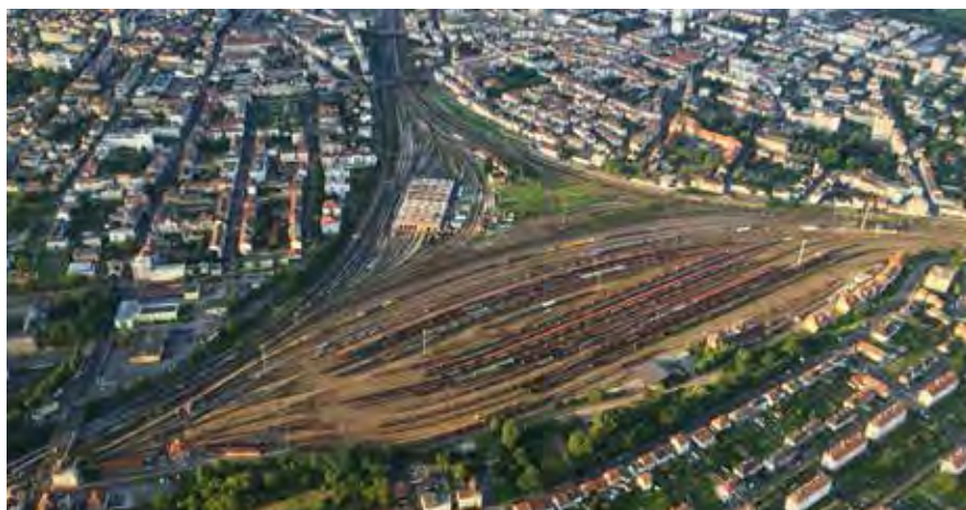
Gare de Metz vue du ciel
