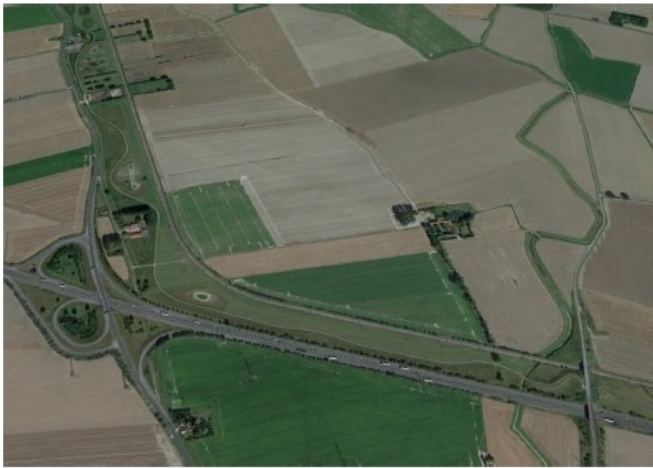
Zone d'implantation de la future station de conversion (source : Google Earth®)
