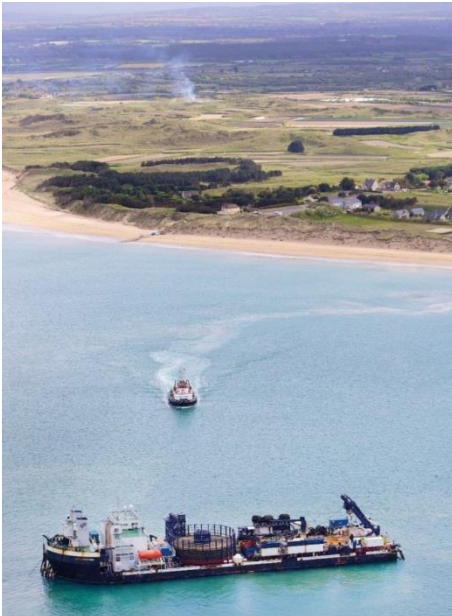
Navire Câblier : navire spécialisé dans la pose des câbles sous-marin pour le transport d'énergie électrique (Source : Prysmian)
