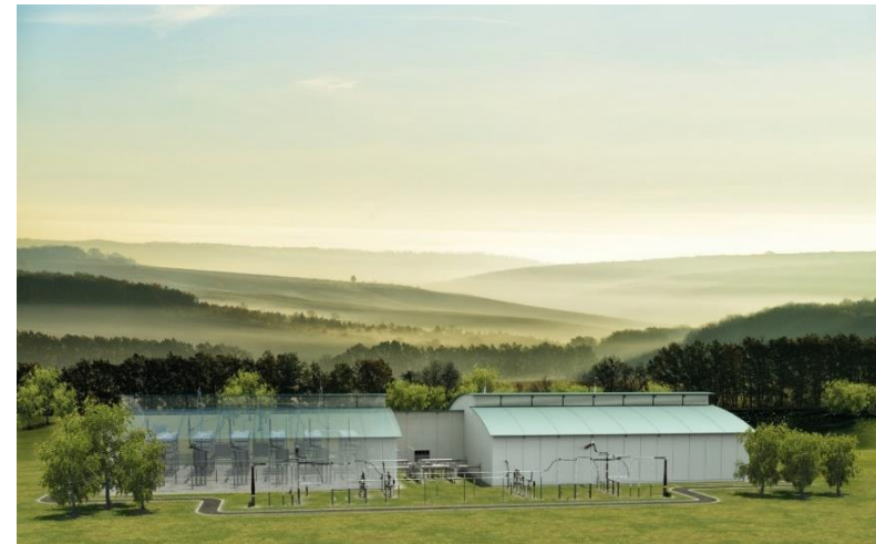
Modèle type d'une station de conversion (Source / propriété : Siemens)
