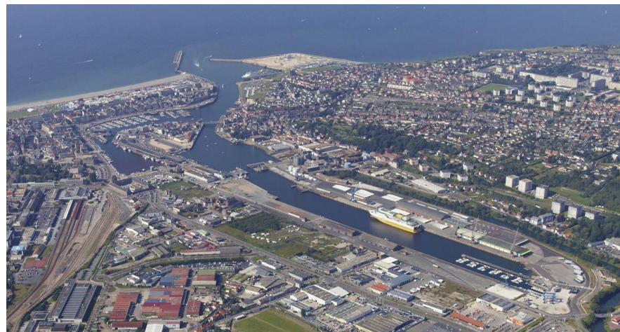
Port de Dieppe, support d'un trafic maritime très dense
