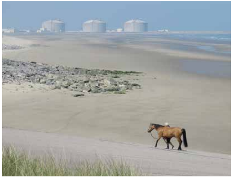
▲ Une promeneuse sur la digue du Braek, au loin le terminal méthanier
