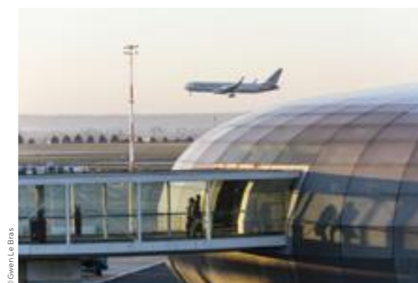
Vue extérieure du Satellite A du Terminal 2, Paris-Charles de Gaulle
