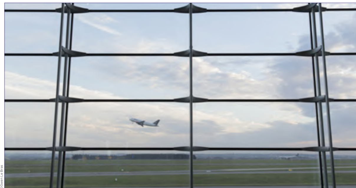
Belvédère du Hall L au Terminal 2E à Paris-Charles de Gaulle
