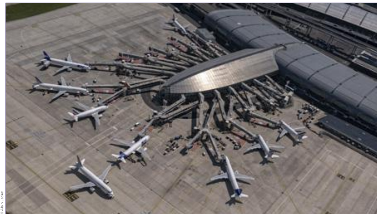
© Alain Leleuc Vue aérienne du Terminal 2F à Paris-Charles de Gaulle
