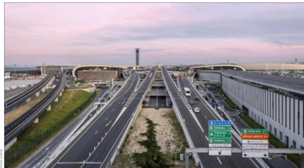
Viaduc entre les terminaux 2E et 2F, Paris-Charles de Gaulle
