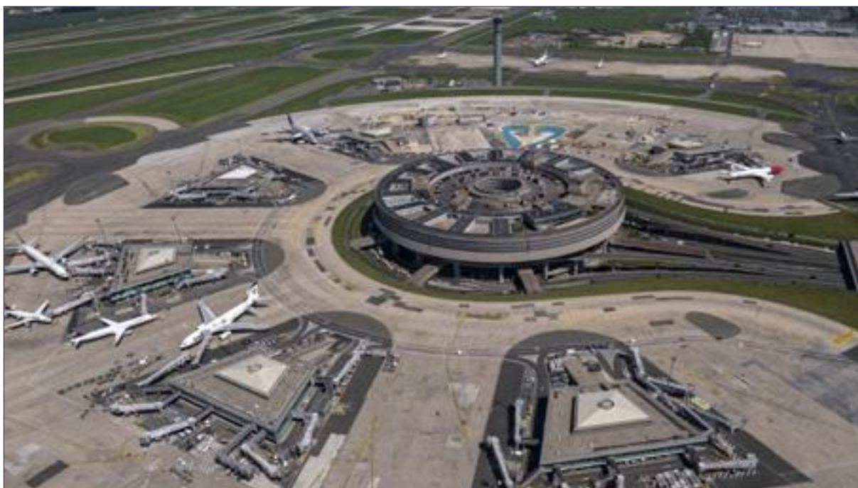
© Alain Leleuc Vue aérienne du Terminal 1 à Paris-Charles de Gaulle
