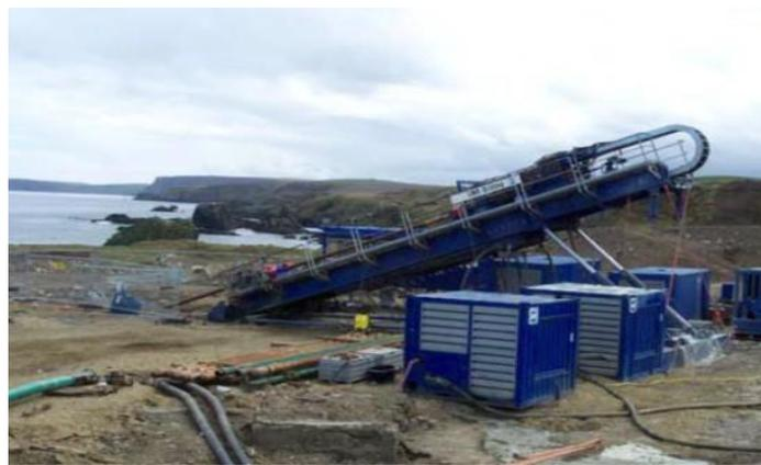
*Représentation schématique et exemple de travaux de travaux de pose par forage dirigé*
