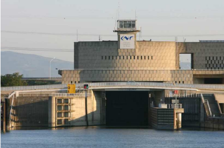
Ecluse de Châteauneuf-du-Rhône (© CNR)
