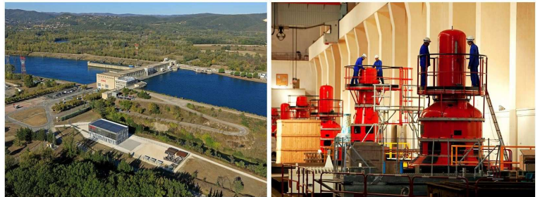
Usine de Montélimar et ses groupes de production (© CNR)
