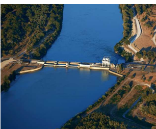
Exemple du barrage-usine de Seyssel (© CNR)
