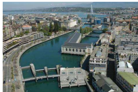
Le barrage usine du Seujet à Genève (© SIG, R. Multari)
