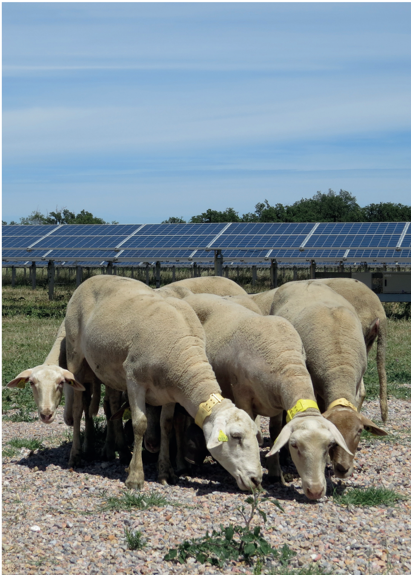
Parc photovoltaïque Arkolia Énergies Le Soler
