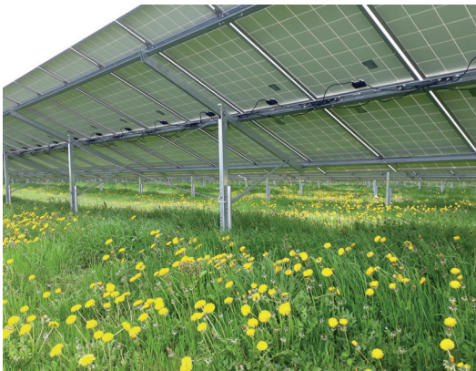
Parc photovoltaïque Arkolia Énergies Le Bastit
