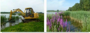
Aménagement / réalisation de marais, zones humides (marais, chenaux, ouvrages hydrauliques...)
