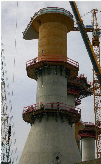
Fabrication et stockage des fondations
