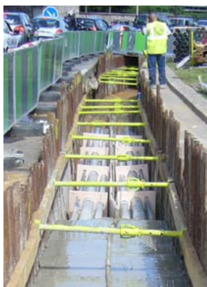
Chantier d'une liaison double souterraine
