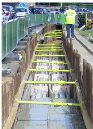
Chantier d'une liaison double souterraine
