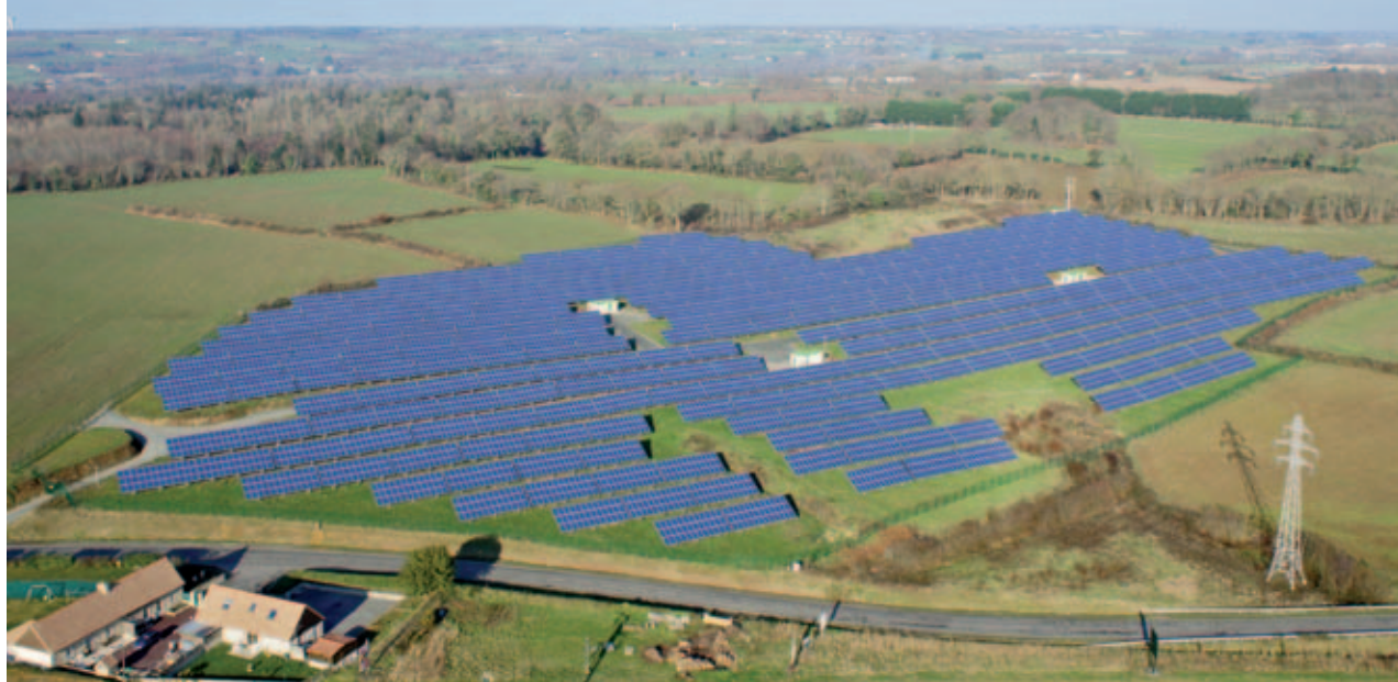
/// Centrale solaire de Lannion inaugurée en janvier 2012 (NEOEN)
