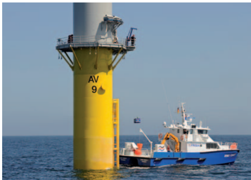
/// Bateau de maintenance en intervention
