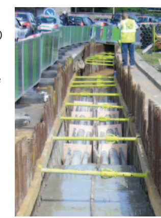
Chantier d'une liaison double souterraine
