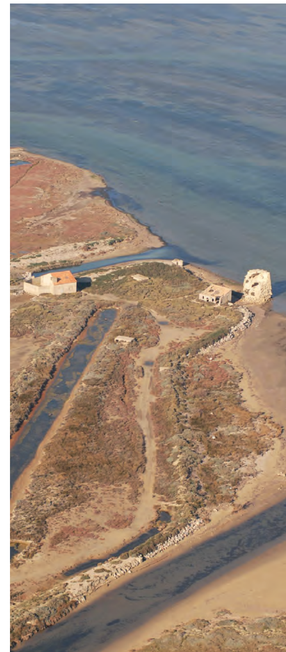
Limite Nord de la Réserve Naturelle Régionale (installations de pompage des anciens Salins)
