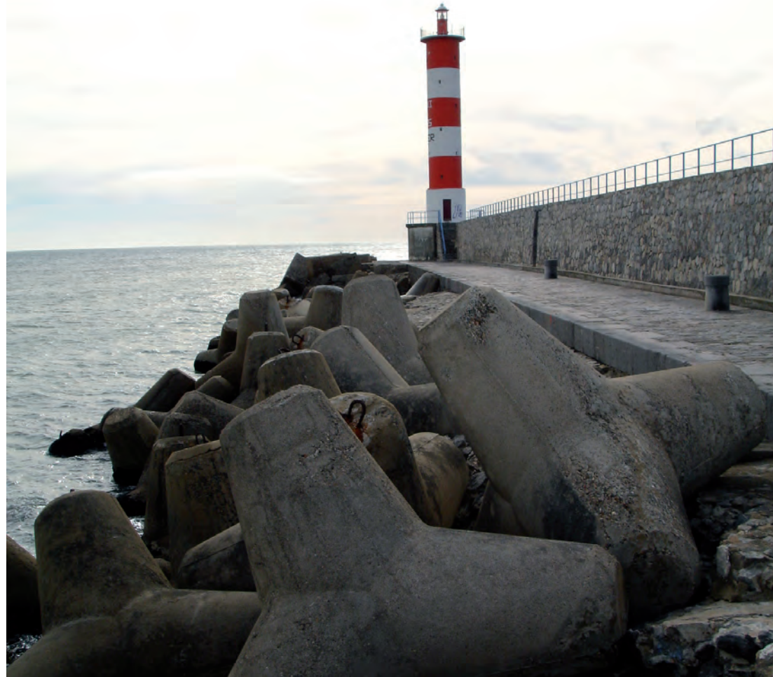
Port-La Nouvelle, digue Sud
