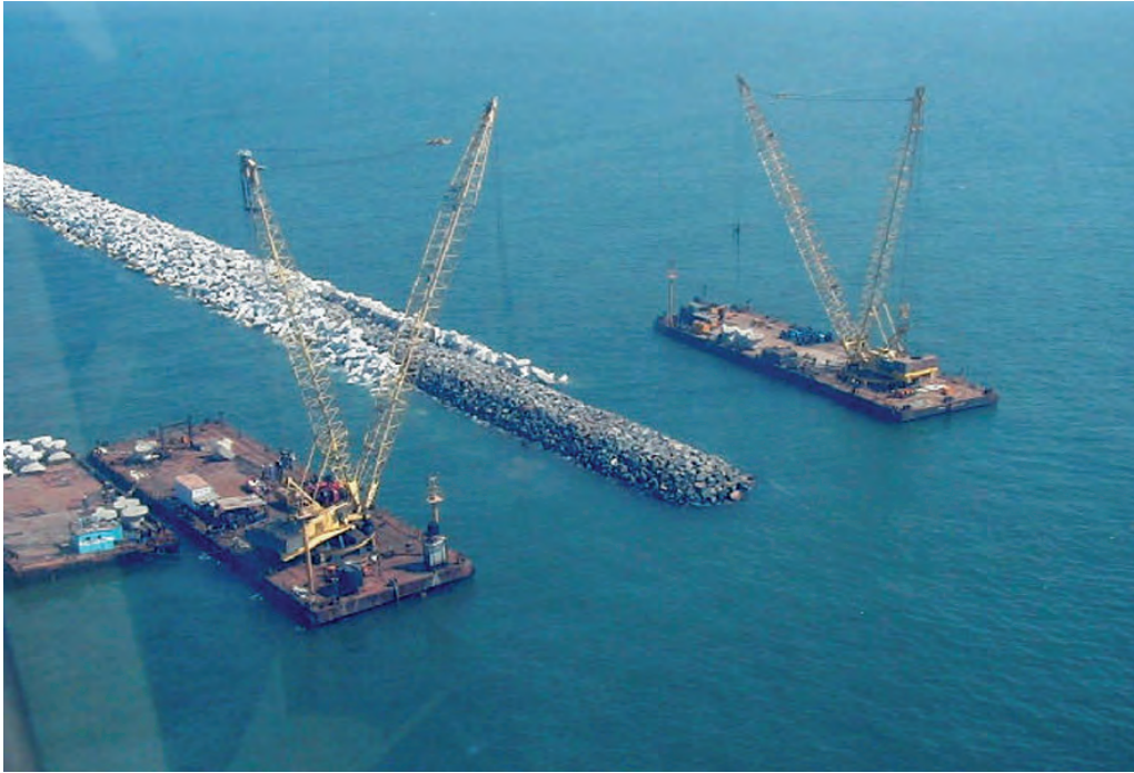
Exemples de chantiers de construction ou confortement de digues en enrochements
