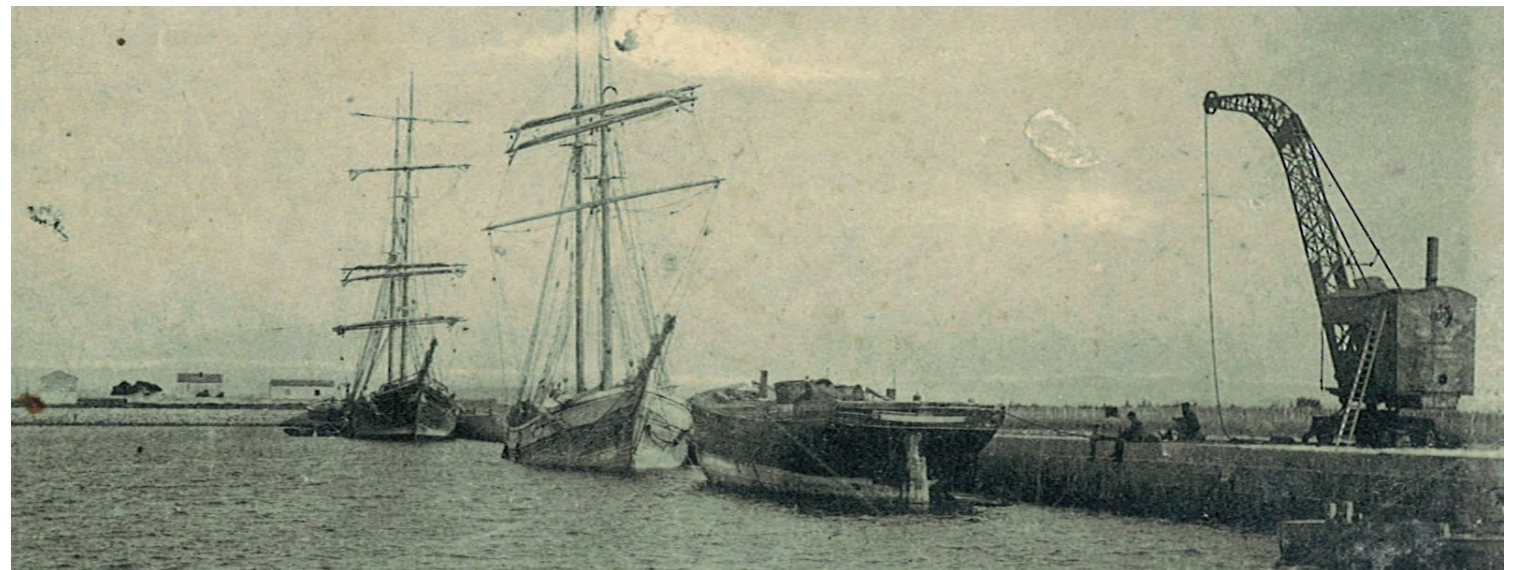
1917, mise en place d'une grue de 3 tonnes
