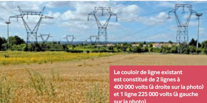
Le couloir de ligne existant est constitué de 2 lignes à 400 000 volts (à droite sur la photo) et 1 ligne 225 000 volts (à gauche sur la photo). Demain, cette dernière ligne sera transformée en 400 000 volts.
