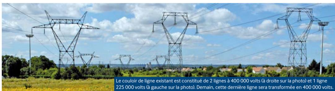
Le couloir de ligne existant est constitué de 2 lignes à 400 000 volts (à droite sur la photo) et 1 ligne 225 000 volts (à gauche sur la photo). Demain, cette dernière ligne sera transformée en 400 000 volts.
