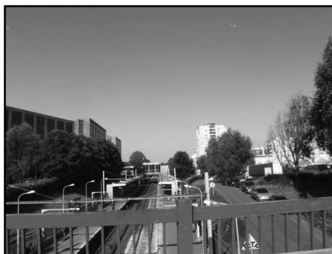
Figure 142 : Les quais de la ligne A du RER
