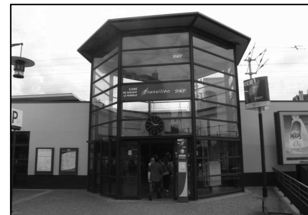
Figure 117 : Bâtiment voyageurs existant de la gare de "Nogent - le Perreux" (Source : STIF, 2012)
