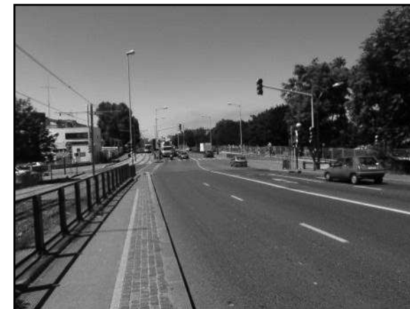
Figure 86 : La RD86 vue vers l'ouest depuis le pont franchissant la grande ceinture, à gauche Bobigny, à droite Drancy
