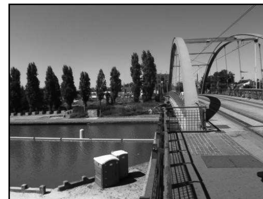
Figure 99 : Vue vers le nord du pont du tramway T1
