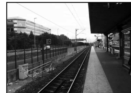
Figure 113 : Vue des quais du RER E longés par l'A 86. (Source : STIF, 2012)
