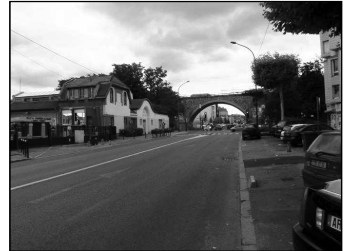
Figure 121 : La RD4 à Champigny au niveau du Pont rail de la Grande ceinture
