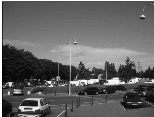
Figure 133: Le parking occupant actuellement les emprises de l'ex A103 dans le quartier des Fauvettes
