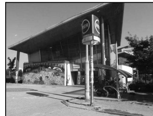
Figure 143 : L'accès existant au RER côté Cité Descartes
