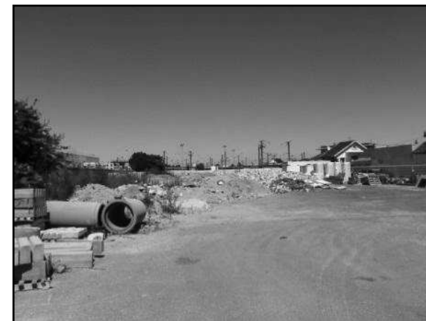
Figure 89 : L'est du site proposé pour l'implantation de la station de la Ligne Orange du Grand Paris Express
