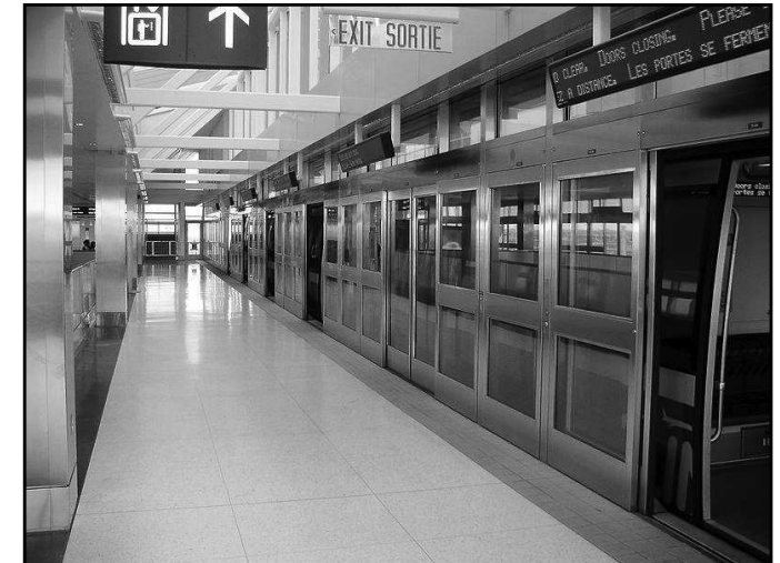
Figure 50 : Portes palières dans une station de train (Toronto Pearson International Airport – Canada).
