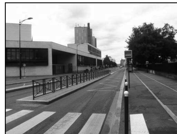
Figure 101 : Vue vers le nord du pont du tramway T1 (à gauche) et rue Jules Guesde
