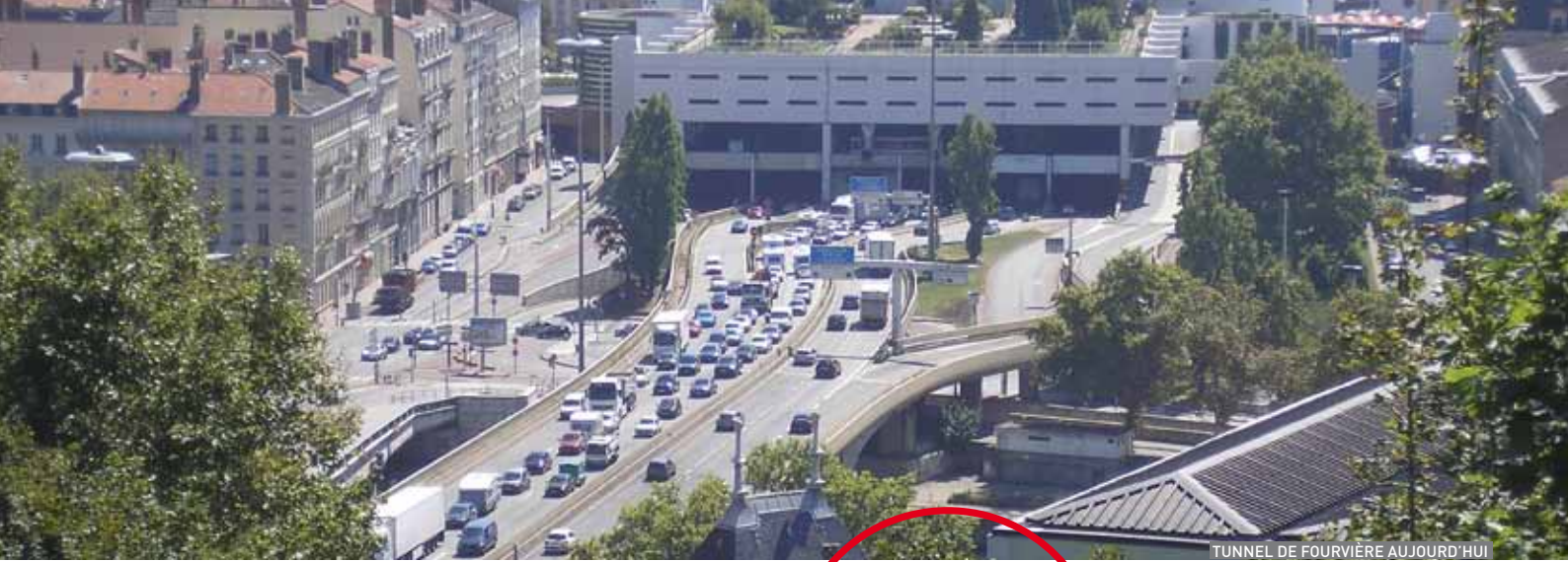
TUNNEL DE FOURVIÈRE AUJOURD'HUI
