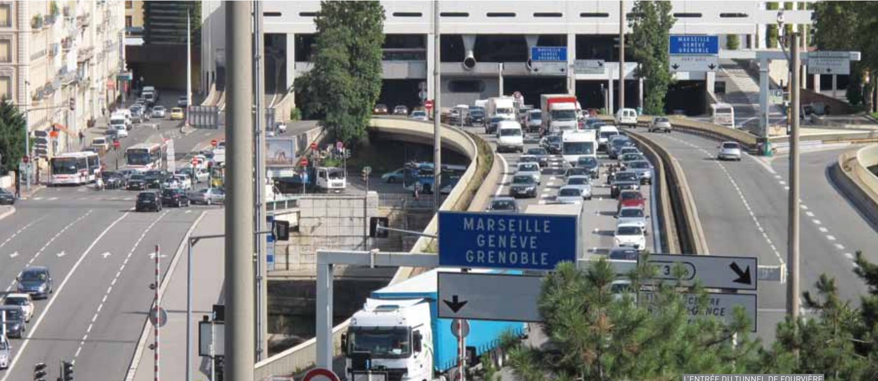
L'ENTRÉE DU TUNNEL DE FOURVIÈRE
