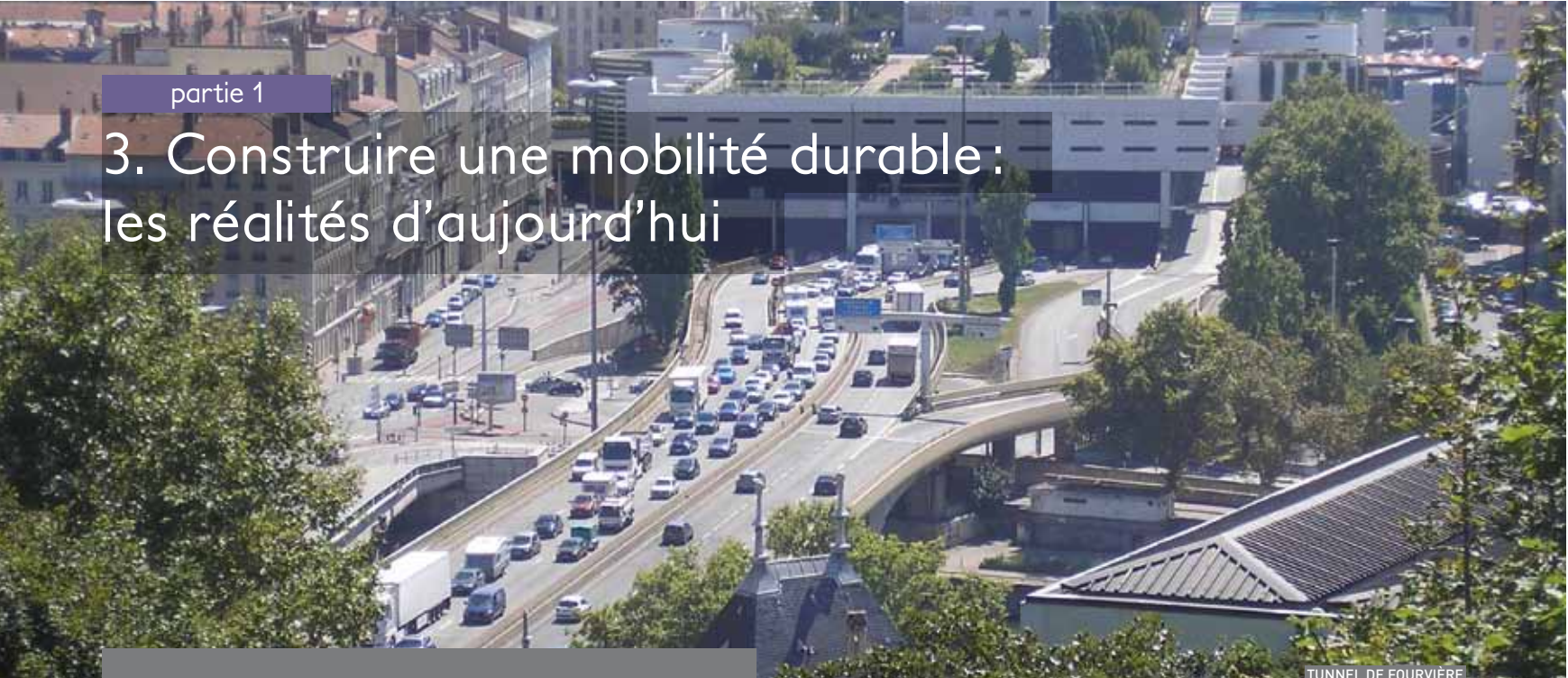
TUNNEL DE FOURVIÈRE
