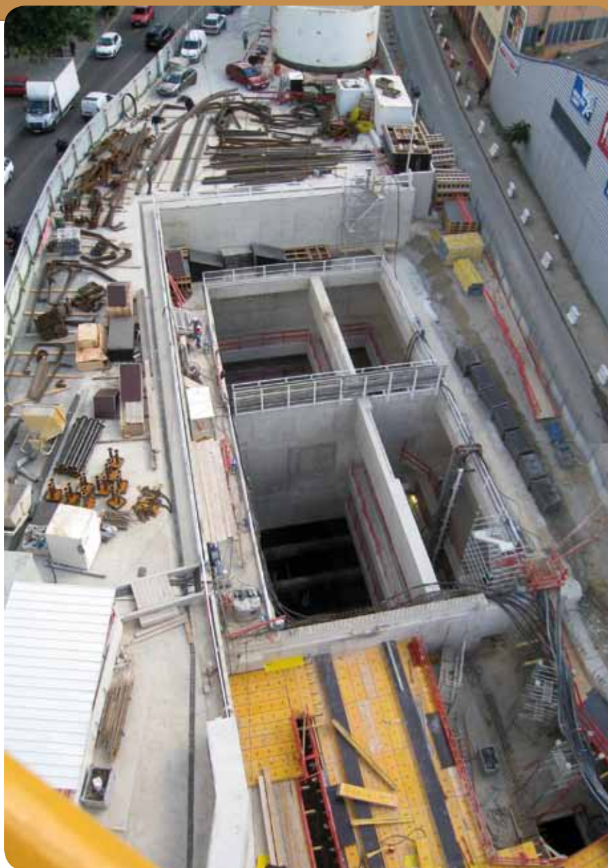
Puits de descente du tunnelier sur le prolongement de la ligne 12 en cours de travaux
