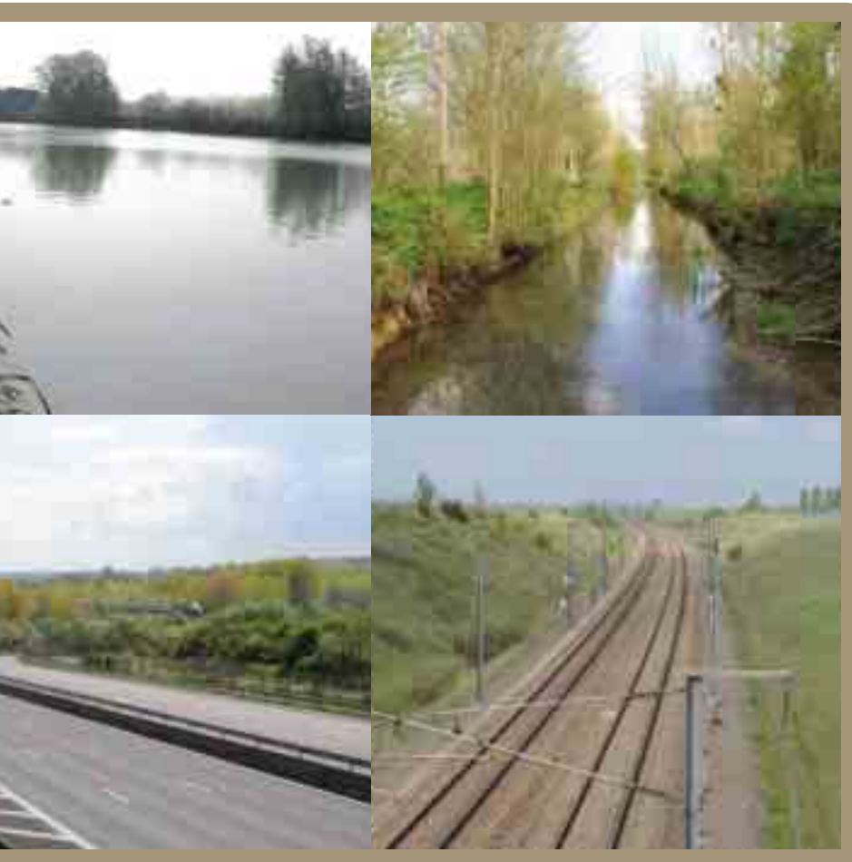
⚡ Plusieurs obstacles à franchir : voies ferrées, routes, voies d'eau...
